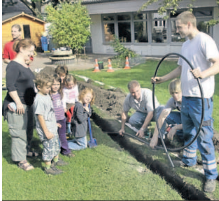
LSW-Mitarbeiter (von rechts) Holger Stackfleth, Sandrino Benecke und Daniel Buschmann legen eine Wasserleitung im Kindergarten St. Altfriid.
