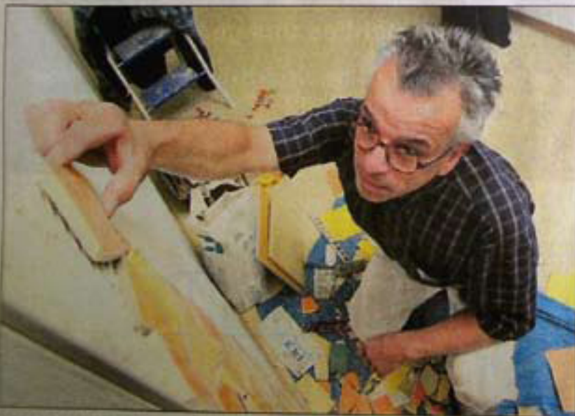
Fliesenleger Rainer Bauer arbeitet an einem Torbogen.
